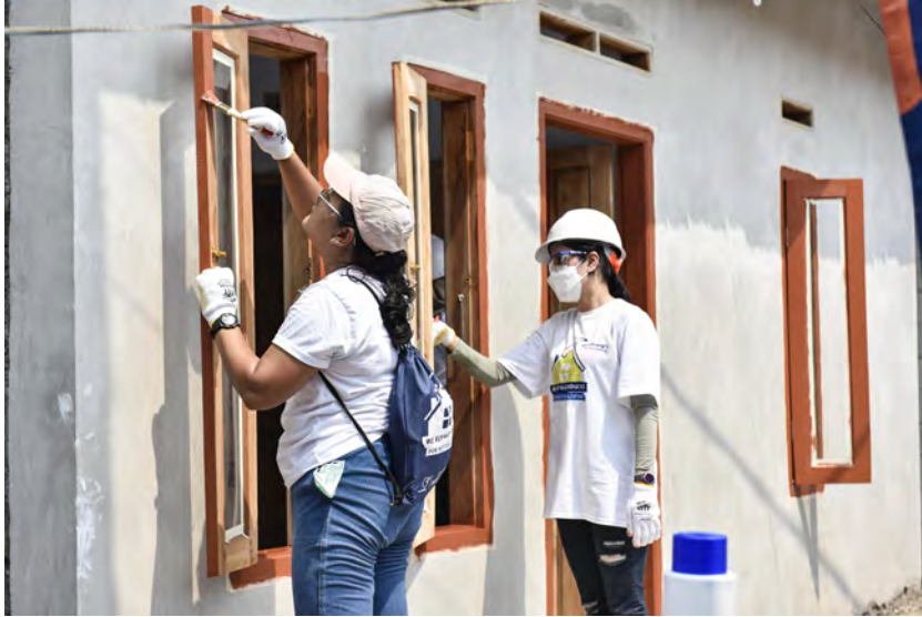
Para relawan bekerja membangun rumah baru untuk warga Mauk, Tangerang.
